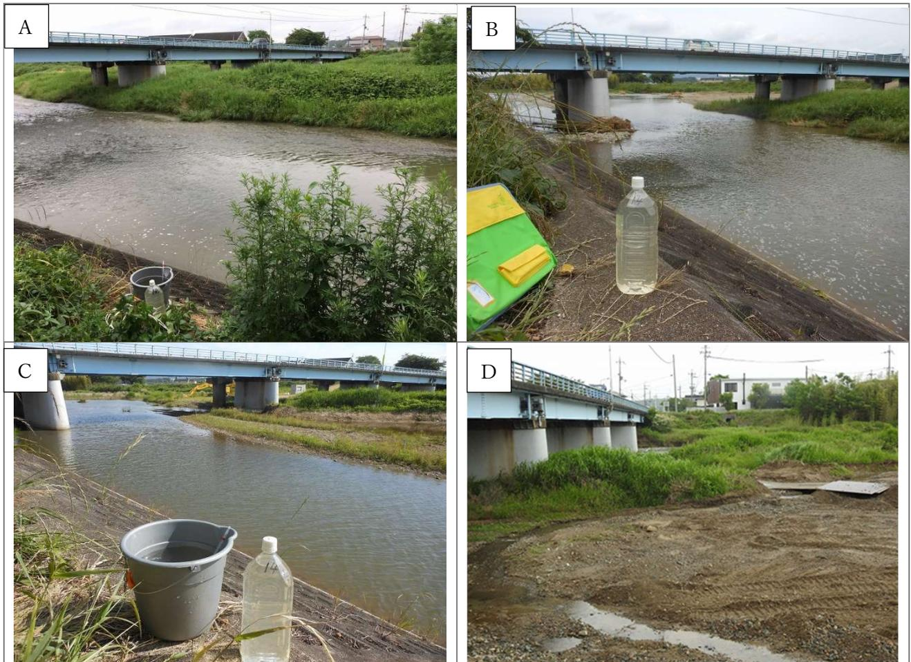
市子橋周辺の佐久良川では、2021年3月から先ず市子橋下流側（写真で右から左に流れています）の浚渫作業が行われ、次いで2022年5月～7月に橋上流中央から左岸寄り側が浚渫され、2022年12月～2月に橋上流中央から右岸が浚渫されました。また、2021年9月の台風による大水で左岸側護岸が一部損傷し、その修復工事が今年3月～6月に実施されました。上記写真は、A:2020年6月（工事実施前）；B:2021年6月；C:2022年6月；D:2024年6月です。護岸修復工事は河道内に重機を入れて工事する必要があったため、重機やダンプの通路確保のため、土砂が入っています。護岸修復工事に際しては、魚の救出作業を実施しました。
