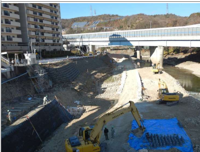
2021 年 大型ブロック護岸に改修中
